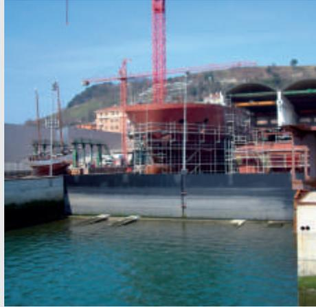
Con la mejora y ampliación de las calles de varada se ha conseguido un serio avance. A las calles de varada de nueva construcción se les concedió un muro lateral de 60m y dos puertas frontales. En resultado, el astillero es capaz de construir buques de 85m de eslora, y, si fuese necesario, con una manga de hasta 30m. El muro lateral también se usará como apoyo para una grúa de acero, que podrá manejar bloques directamente en las calles de varada para proyectos futuros.
